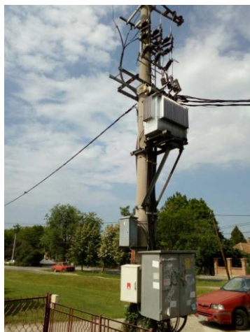
Slika 5a – Spoljna ugradnja MKO ormana (stubna)
